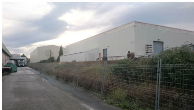
Vue de la partie terminale de l'emprise ferroviaire depuis le MIN (sites embranchés)
