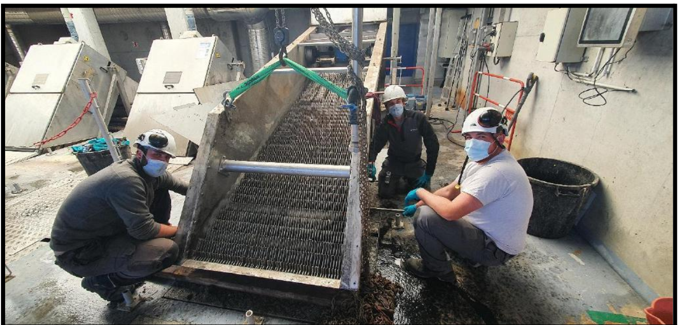
Apprenti MELEC (Gauche) + BTS GEMEAU (Droite au fond) supervisés par un électromécanicien – Entretien dégrilleur fin n°3
