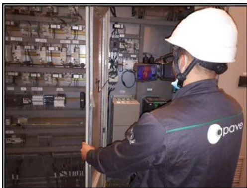
Contrôle thermographique réalisé en 2022
