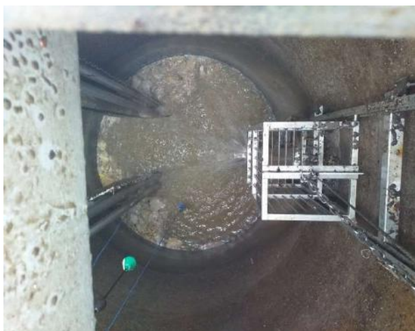
Figure 2 - PR Village - Saint-Drézéry - cuve avec panier dégrilleur
