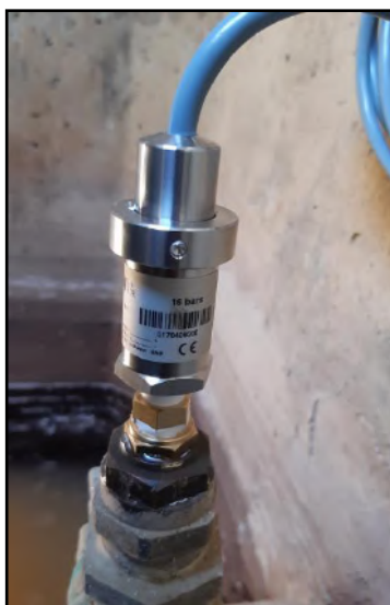
Capteur de pression PR Mas de Figuières
