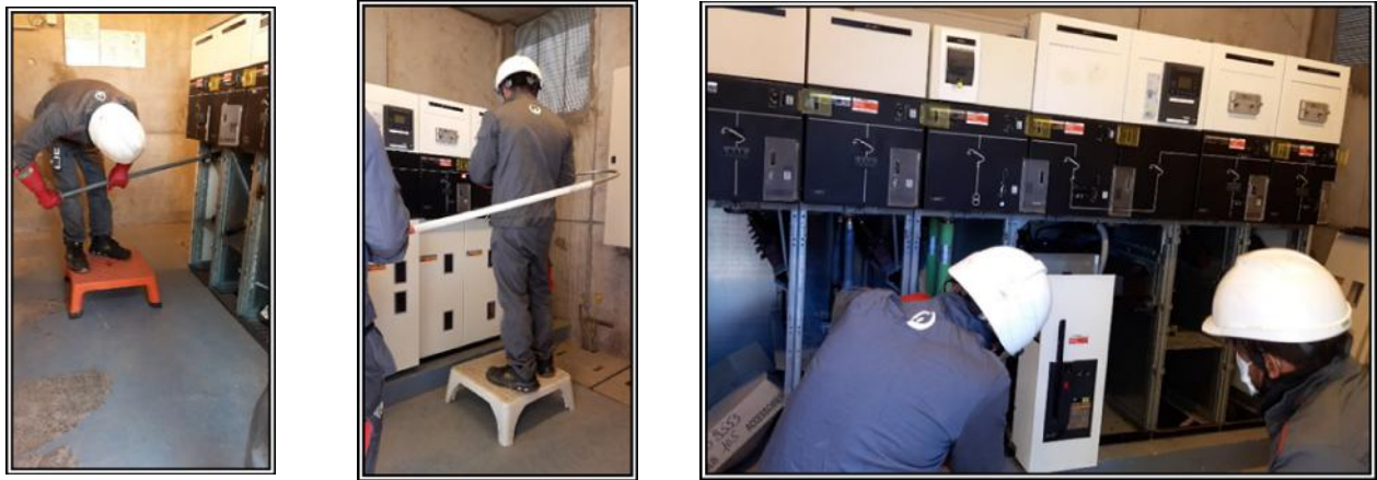
Entretien annuel des cellules HT et du poste de livraison
