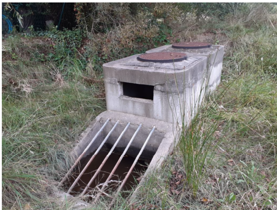
Vue d'un dégrilleur dans un bassin de rétention
