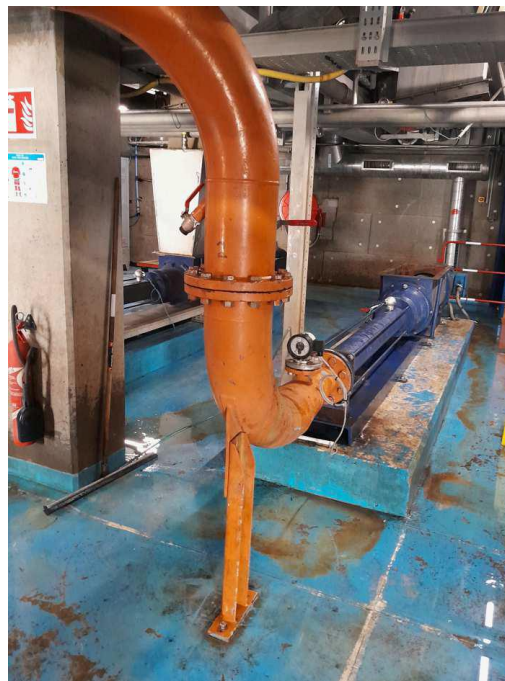
Renouvellement des pompes boues à la station de MAERA
