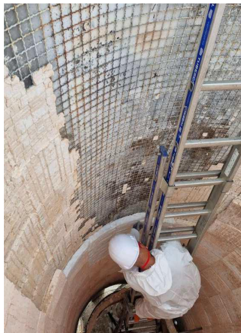
Réparation de la torchère à la station de MAERA
